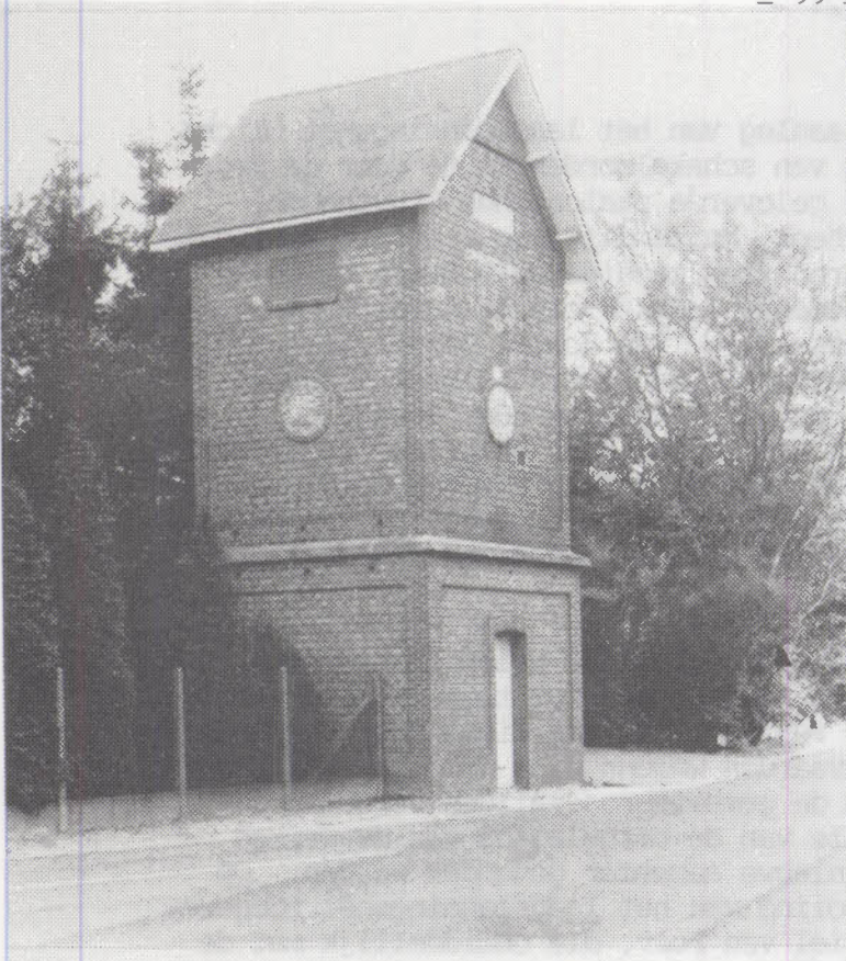
Transformatiecabine aan de Beemdstraat
